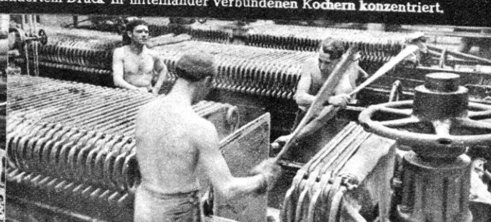
In den Schlammpressen werden Saft und Niederschlag durch Filtrieren getrennt. Der Schlammkuchen mit den Nichtzuckerstoffen bleibt in den Pressen zurück.
