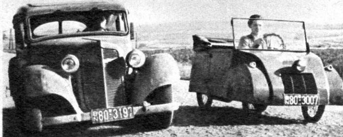
„Marbo“: Die Vorteile dieses neuen deutschen Kleinautos, das von der Firma Fichtel & Sachs mit einem 98-ccm-Motor herausgebracht wurde und das 30 km Geschwindigkeit hat, liegen in seinem niedrigen Brennstoffverbrauch, der leichten Bedienung und niedrigen Besteuerung.
