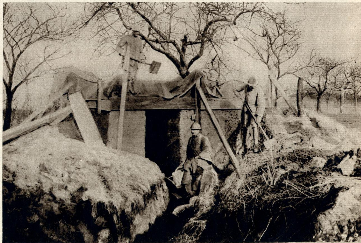
Aabri bétonné pour mitrailleuse. — A cemented machine-gun shelter. — Ricovero di calcestruzzo per mitragliatrice. — Abrigo cimentado para metralhadora. — Abrigo de hormigón para ametralladora. — Ein betonniertes Mitralleusen-Versteck.
