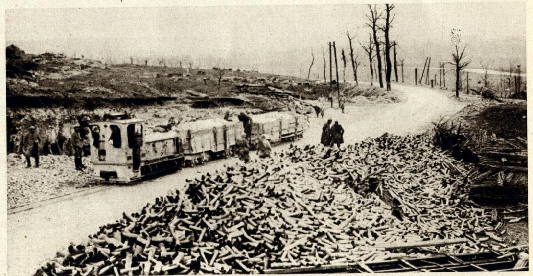
L'aménagement du terrain reconquis. — Organising the reconquered territory. — L'asestamento del terreno riconquistato. — O preparo do terreno reconquistado. — Reparación del terreno reconquistado. — Instandsetzung des eroberten Terrains.
