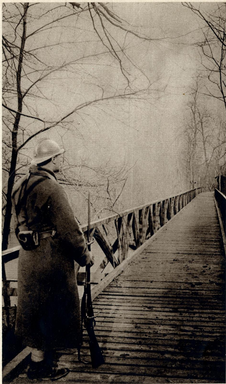
Une passerelle. — A foot-bridge. — Una palancola. — Um passadizo. — Un pasadizo. — Ein Steg.
