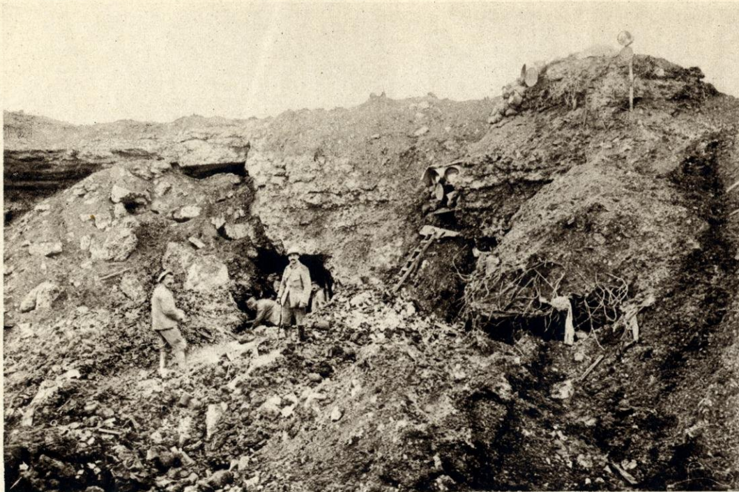
Une vue du fort de Douaumont. — A view of Douaumont fort. — Una vista del forte di Douaumont. — Uma vista do forte de Douaumont. — Una vista del fuerte de Douaumont. — Eine Ansicht des Forts von Douaumont.
