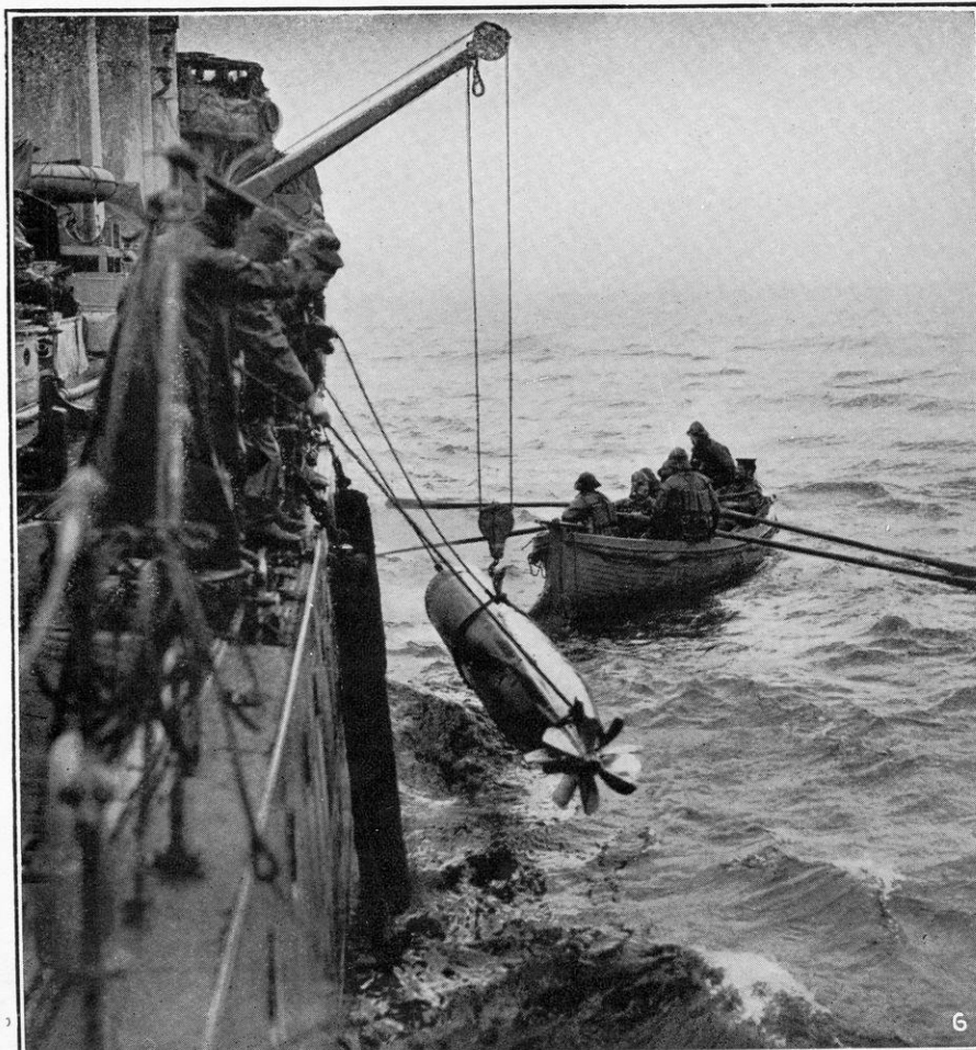
Torpedoøvelser paa en britisk Jager.—1. Rørene paa Dækket gøres rede til Affyring. 2. Torpedoen afskydes. 3. Torpedoen forlader Røret. 4. Torpedoen naer Vandet. 5. Torpedoen stiger atter op til Overfladen. 6 og 7. Torpedoen tages atter ind efter sit Øvelsesløb.
