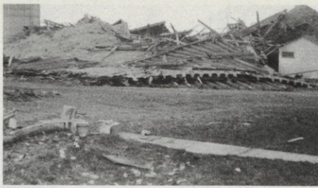
Len & Judy Berg barn - windstorm damage April 27, 1984
