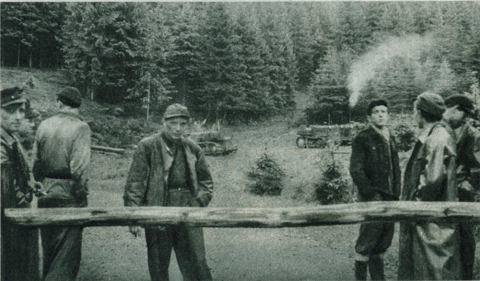
Der Kontrollstreifen geht auch durch die Grenzwälder. Bäume und Sträucher müssen weichen. Im Hintergrund sieht man russische Traktoren, die für diese Arbeiten herangeschafft worden sind.
