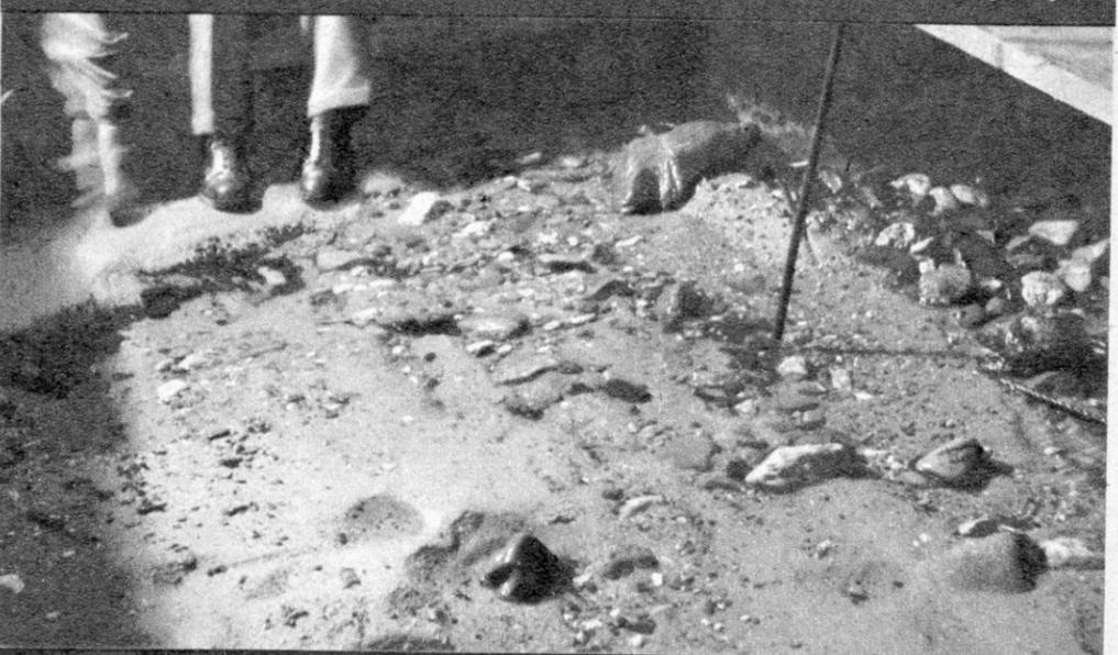
Ist ein größeres Stück gefunden, wird die Glocke auf Grund gesenkt, und man kann trockenen Fußes auf der Sohle des Flusses stehen. Mit dem Schneidbrenner werden Löcher in die Eisentrümmer geschnitten, Drahtschlupps durchgezogen und Bojen daran befestigt. Später kommt der Schwimmkran und zieht die Stücke hoch.
