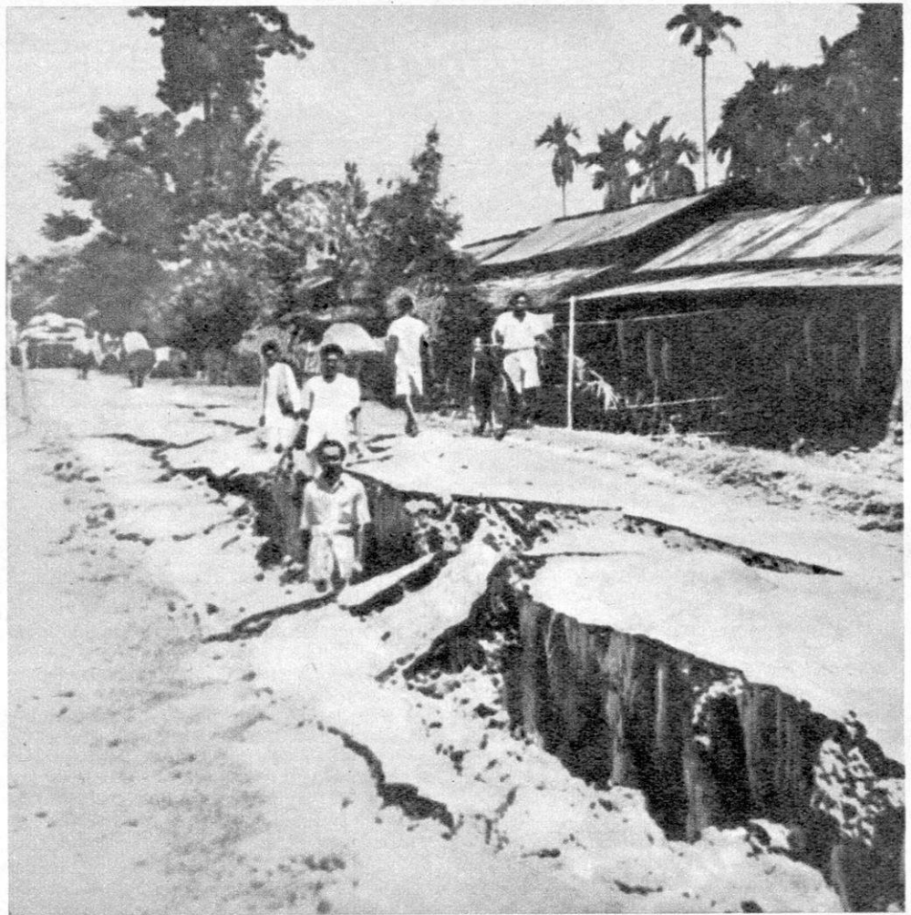
Tiefe Erdrisse. Am 27. August 1950 wurden heftige Erdstöße in Assam, Hinterindien, registriert. Das ganze Gebiet von Doom Dooma und Dibrugarh ist mit tiefen Erdrissen durchfurcht. Foto: dpa
