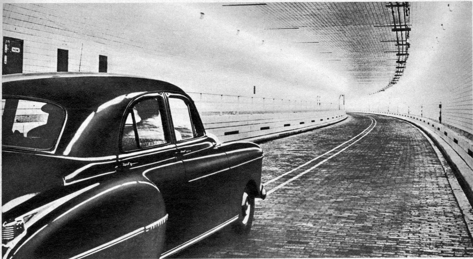
Der Brooklyn-Battery-Tunnel, 2735 m lang und 34,5 m unter dem Wasserspiegel, verbindet die Manhattan-Insel mit dem Stadtteil Brooklyn.
