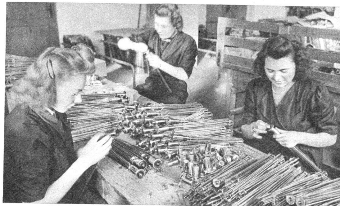
Während der Schirmbezug nach dem Zuschneiden zum Nähen einen eigenen Weg geht, ist das Gestell zusammengesetzt worden. Die Stangenenden haben Zelluloidspitzen erhalten, und der Griff wird aufgesetzt.
