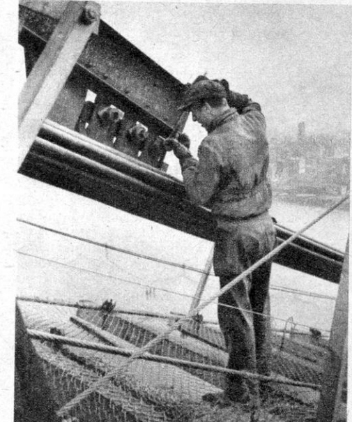
Da alle Kabelstränge parallel laufen und die gleiche Spannung aufweisen müssen, werden sie nach dem Einziehen sorgfältig gerichtet und eingeregelt.
