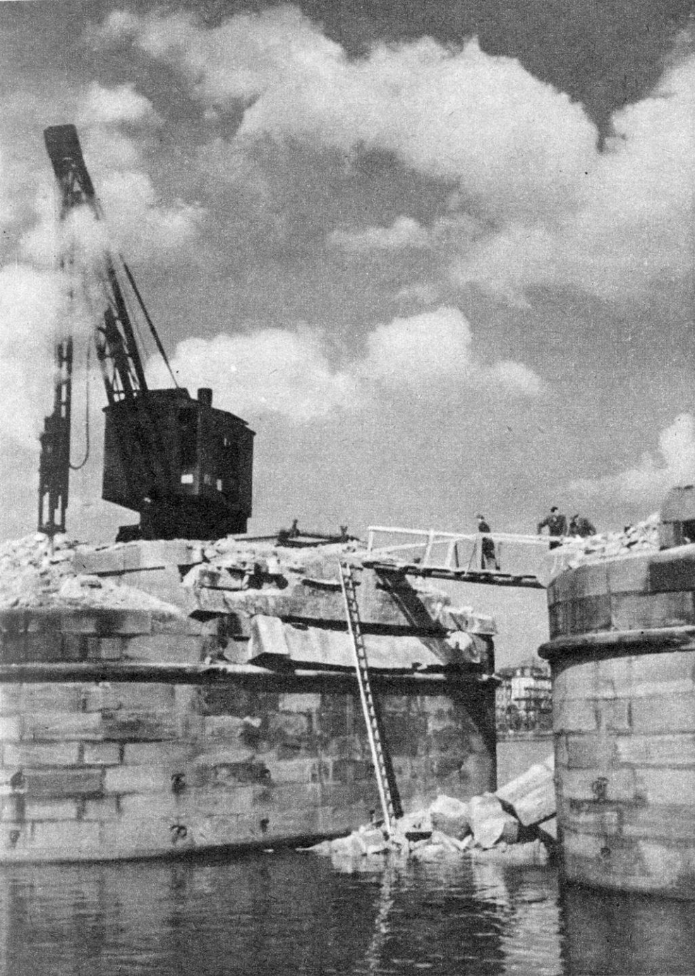
So sahen nach dem Kriege die meisten Brücken aus: entweder gesprengt oder durch Bomben zerstört.
