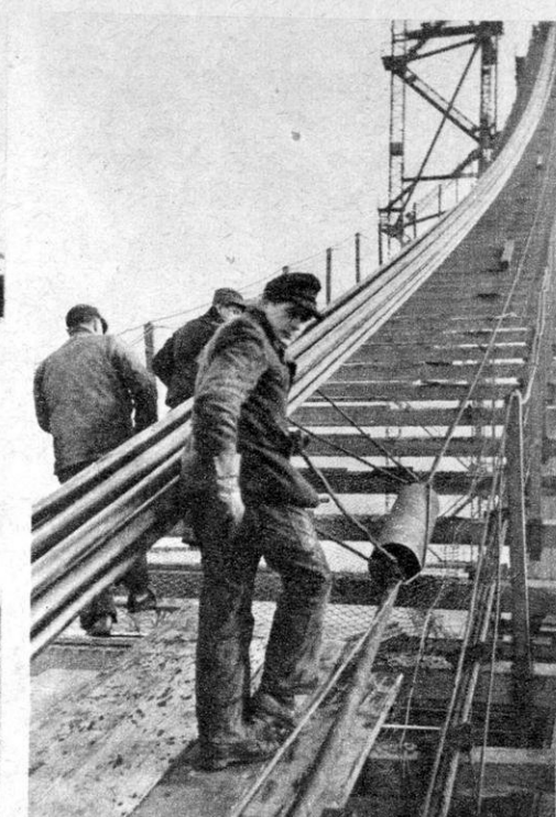
Brückenbau ist stets gefährvolle Arbeit, doch grenzen die Arbeiten beim Bau der Hängebrücke fast an künstlerische Leistungen. Über die hohen, festen Haupttürme, die sog. Pylonen (die hier 60 Meter hoch waren), wird ein Bausteg aus Maschendraht und Balken geführt, auf dem die Arbeiter wohl hunderte Male hinauf- und hinabklettern, Material schleppen und die Hängegurte, die aus starkem Drahtkabel bestehen, einziehen und befestigen müssen.
