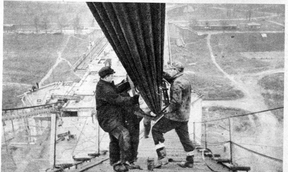
Zusammenfassen zu einzelnen Kabelsträngen. Brückenbau ist in starkem Maße Gemeinschaftsarbeit. Jeder Arbeiter ist auf die Hilfestellung und die unbedingt exakte Arbeit seines Kameraden angewiesen.
