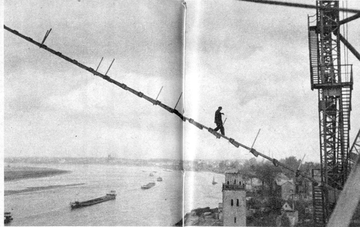
Brückenbau ist stets gefährvolle Arbeit, doch grenzen die Arbeiten beim Bau der Hängebrücke fast an künstlerische Leistungen. Über die hohen, festen Haupttürme, die sog. Pylonen (die hier 60 Meter hoch waren), wird ein Bausteg aus Maschendraht und Balken geführt, auf dem die Arbeiter wohl hunderte Male hinauf- und hinabklettern, Material schleppen und die Hängegurte, die aus starkem Drahtkabel bestehen, einziehen und befestigen müssen.
