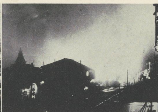
九、一、二四（神戸）神戸市の目抜き通り One of busiest quarters in Kobe razed in fire. Jan. 27.
