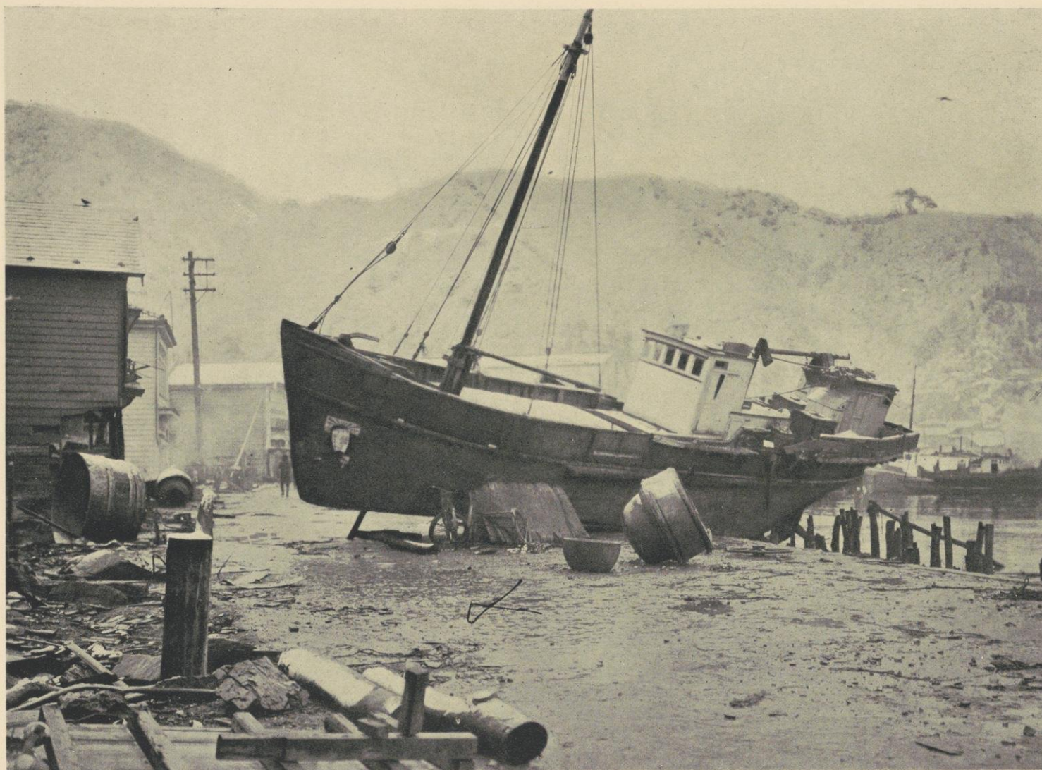
嵐 の 跡 (釜石 三月三日) 岩手日報社 寫 眞 部寫
