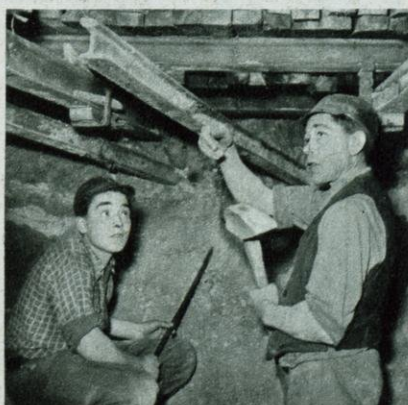
Drei Jahre müssen die Lehrlinge lernen, davon ein Jahr unter Tage. Alle vorkommenden Arbeiten müssen sie beherrschen. Hier der Ausbau der Unter-Tage-Strecken.
