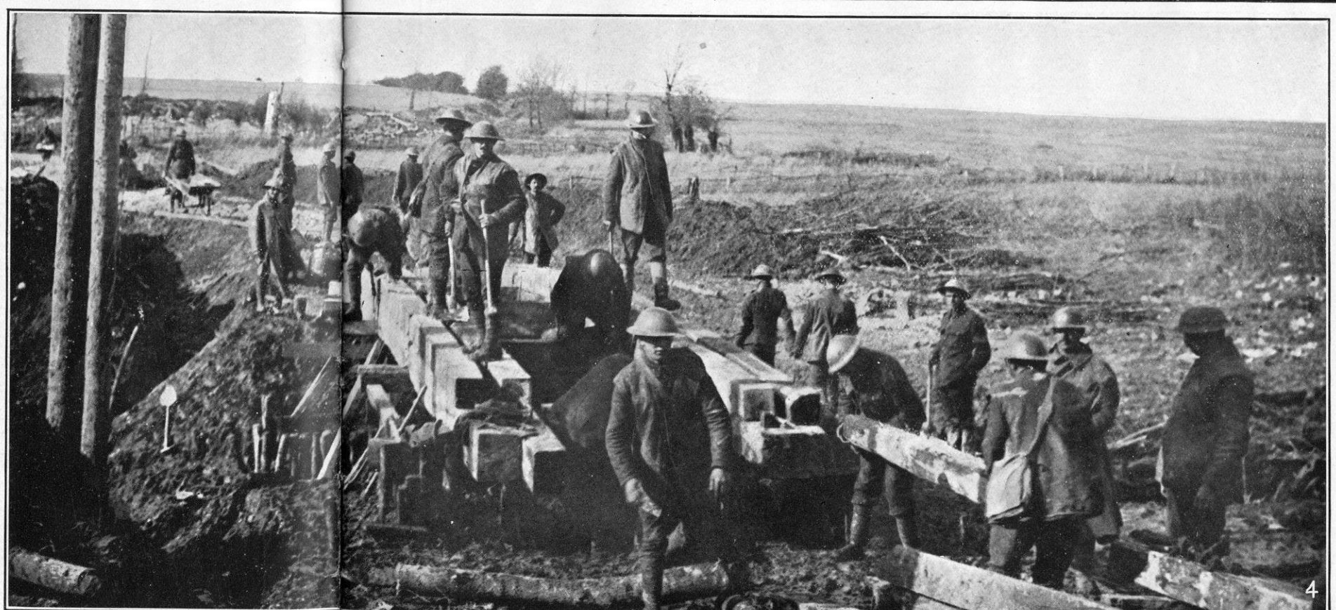
Kongelige Ingeniører i Arbejde ved Brobygning.—1. En midlertidig Bro over Somme. 2. En Bro over en sænket Vej. Den er bygget af Materiale, som Tyskerne har efterladt. 3. En stor Planke til Brobygning rulles frem. 4. Forberedelser til Broslagning over en Strøm.
