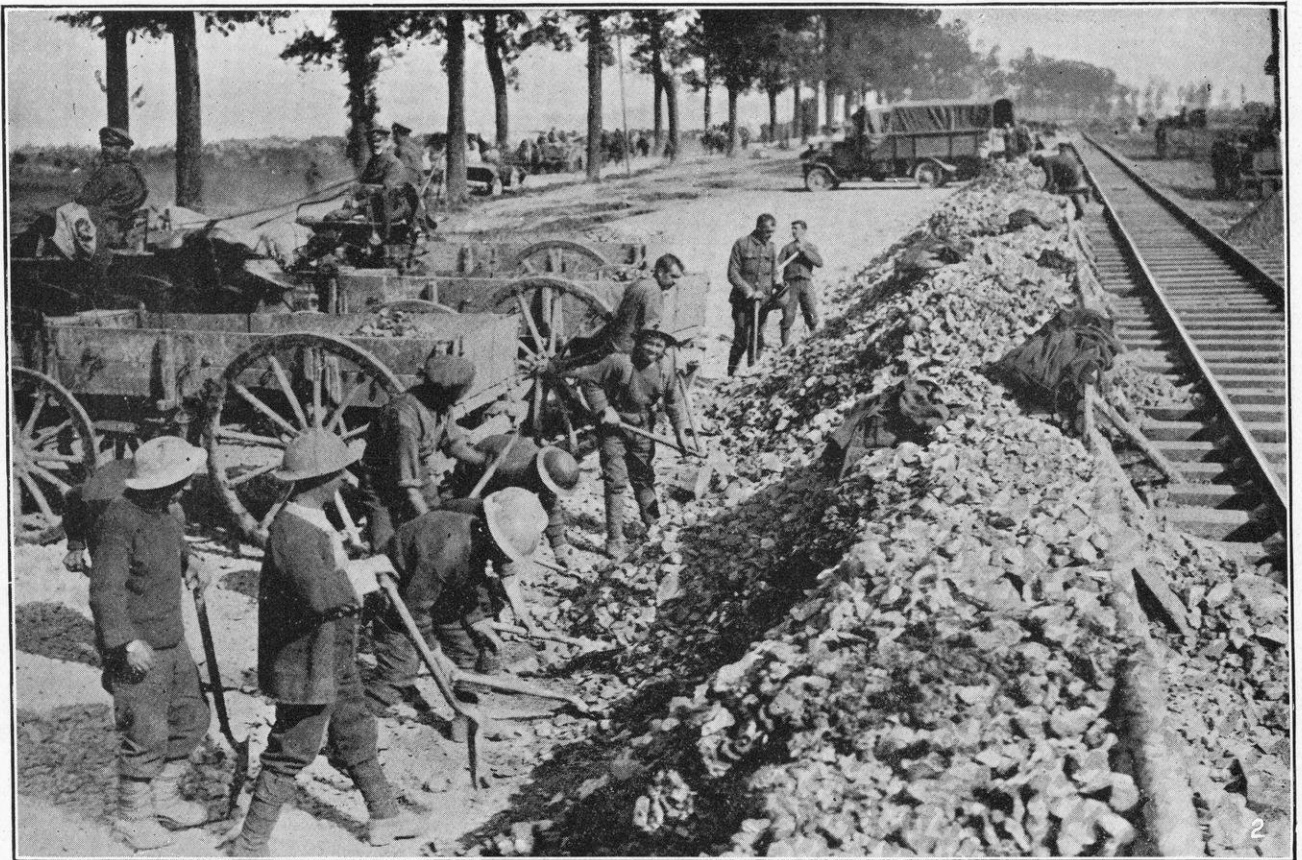
Forberedelser til Vejbygning.—1. Motorvogne læsser ved en Sten- og Grusgrav. 2. En Arbejdsbataillon læsser Sten.
