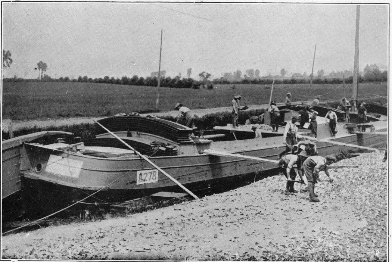
Forberedelser til Vejbygning.—1. Motorvogne aflæsser Sten. 2. Materiale losses fra Pramme.
