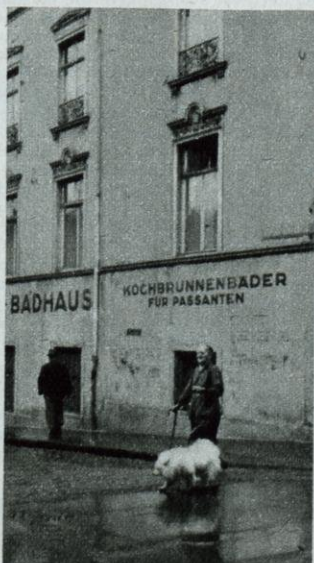
Weniger imposant sind die „Kochbrunnenbäder für Passanten“. Der Baustil der Jahrhundertwende schafft eine beklemmende Atmosphäre in der Stadt. Es war einmal...
