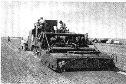
Fig. 8—Flat type traveling mixer
