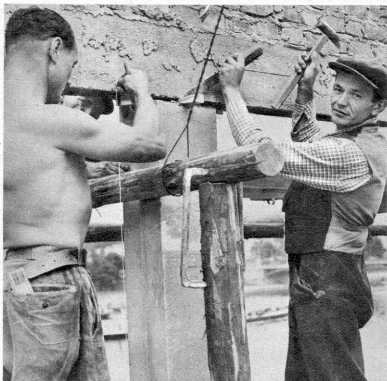
„Hier muß gut und schnell gearbeitet werden“, meint Bauhandwerker M. „Unsere Jugend wartet doch, daß wir fertig werden.“ — Nach 125 Arbeitstagen konnte bereits die Richtkrone über den Rohbau hochgezogen werden. Die Jugend freut sich.
