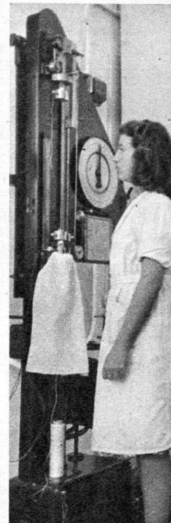
Im technischen Laboratorium. Hier müssen ständig Zerreißproben gemacht werden. Eine Arbeit, die sehr viel Genauigkeit verlangt
