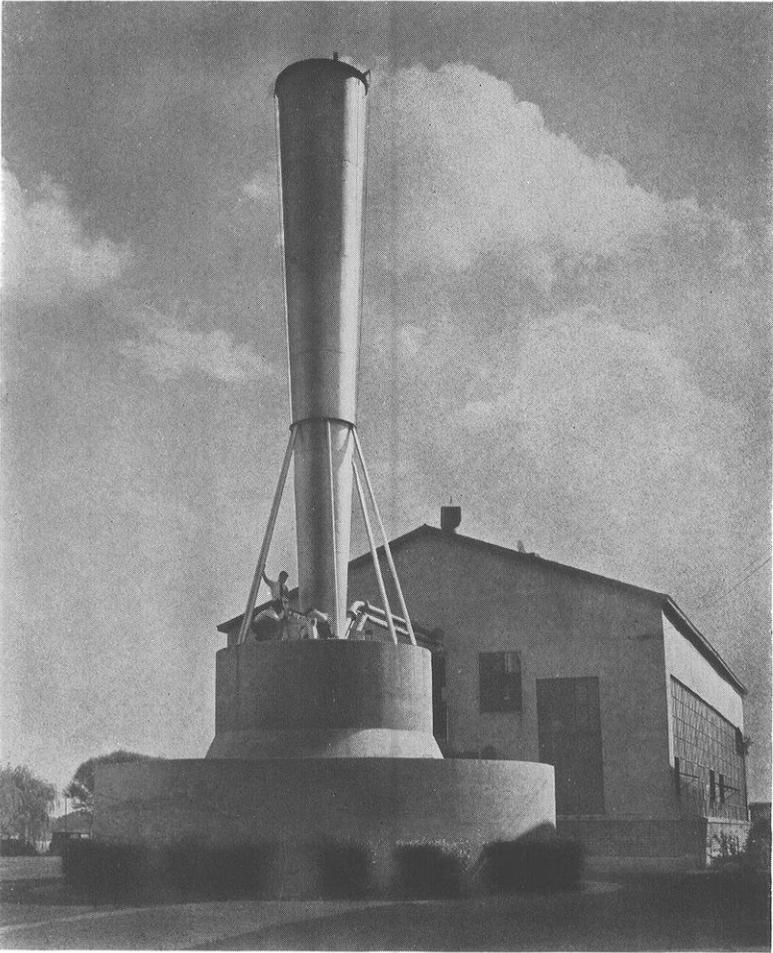
THE N.A.C.A. 2-FOOT HIGH-SPEED WIND TUNNEL
