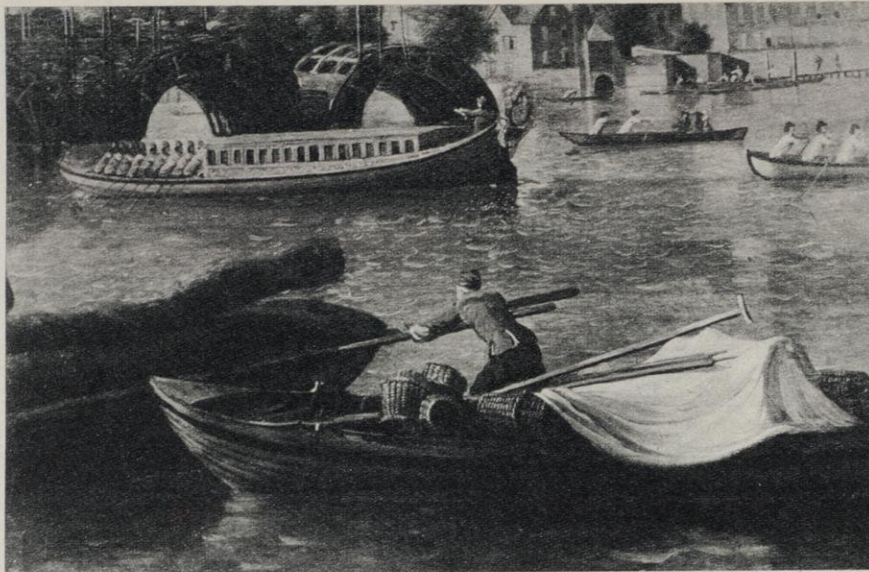
Samuel Scott (1702-1772) „Der Bau der Westminster-Brücke“ (1748), Ausschnitt: Links hinten die Brückenkonstruktion.
