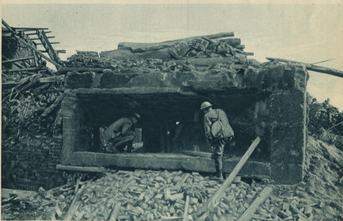
VIRKNINGERNE AF BRITISK GRANATILD: JERNBETON-KANONSTILLINGER, SOM TYSKERNE ER BLEVET NØDTE TIL AT FORLADE.
