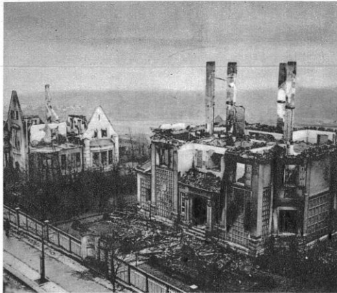
Auf Befehl von Hölz niedergebrannte Villen in Falkenstein U.
